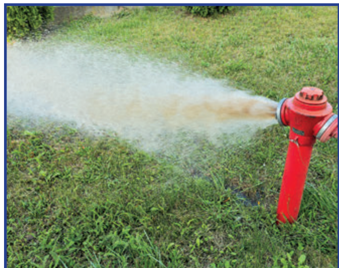
Czyszczenie rur odbyło się z wykorzystaniem soli kamiennej.
