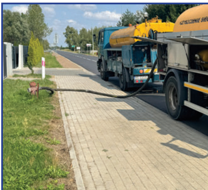
Prace hydropneumatyczne w trakcie czyszczenia sieci wodociągowej.
