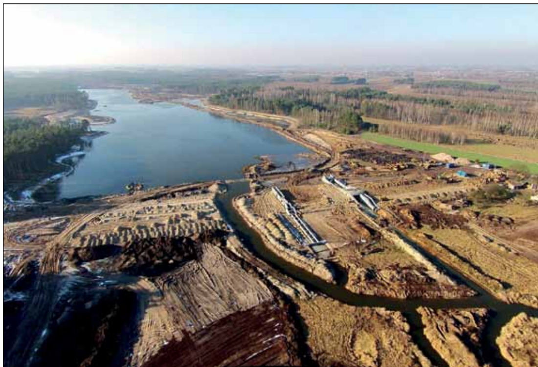
12. Budowa zalewu Jagodno (AUMP)
