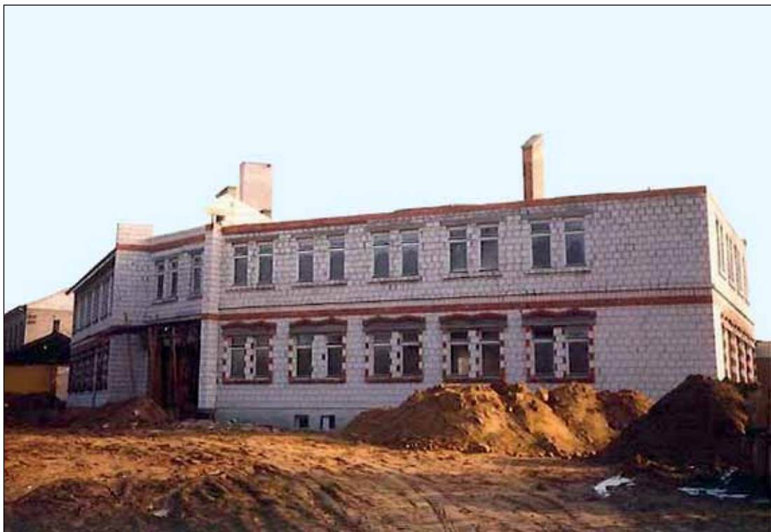
1. Budowa siedziby urzędu gminy w Przytyku (Zbiory Aleksandra Czajkowskiego)
