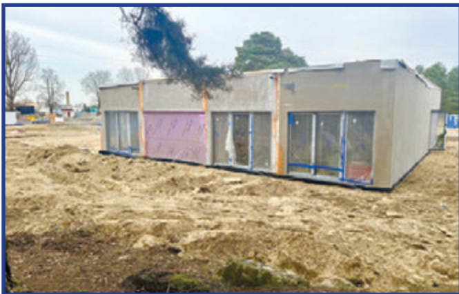
Pod koniec lutego zamontowano pierwsze moduły budynku.
