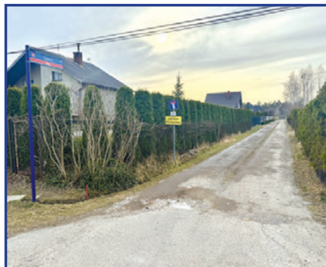
Budowa sieci wodociągowej obejmie w tym roku ulicę Zieloną w Oblesie.
