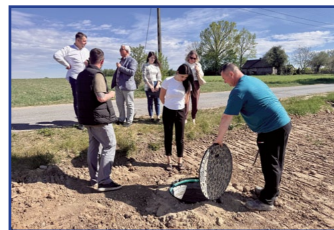
Odbiór prac w miejscowości Zameczek Kolonia.
