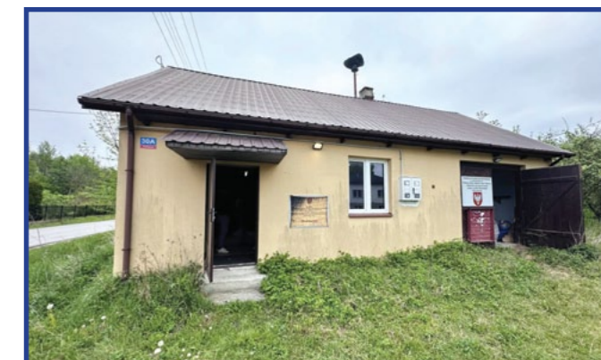
Obecny stan świetlicy wiejskiej w Potkannie – budynek przed rozpoczęciem prac modernizacyjnych.
