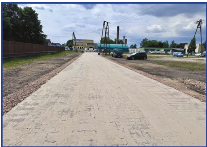
Utwardzona główna aleja targowiska poprawiająca komfort handlu i komunikacji.
