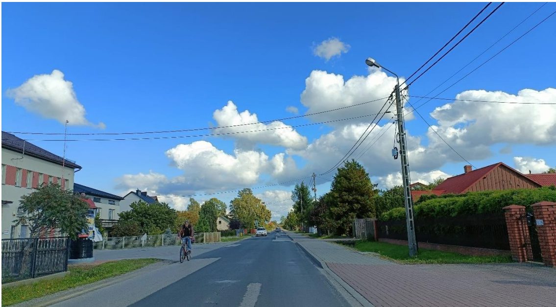
Fot. 4.18 Infrastruktura drogowa na terenie GOFR – brak DDR
