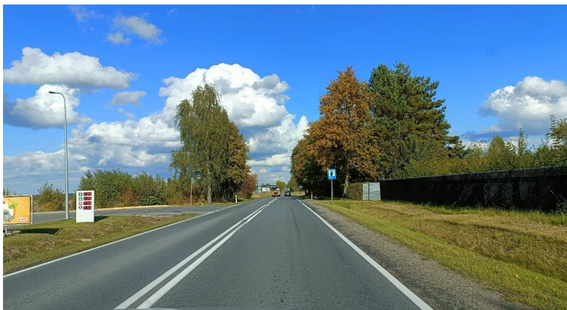
Fot. 4.17 Infrastruktura drogowa na terenie GOFR
