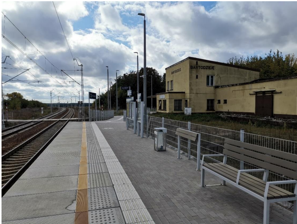
Fot. 4.2 Zmodernizowany przystanek osobowy Bartodzieje
