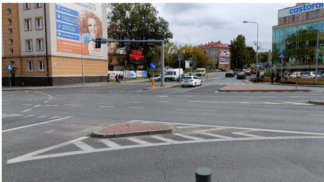
Fot. 4.22 Infrastruktura drogowa na terenie GOFR – skrzyżowanie z wyspami kanalizującymi
