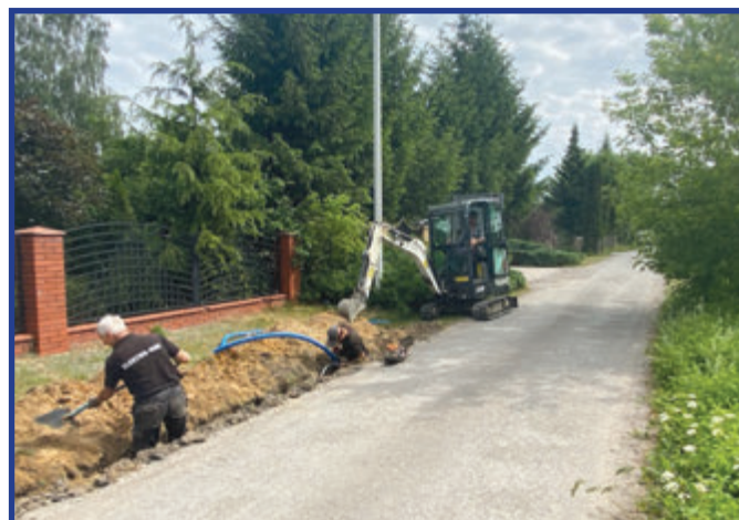
Rozbudowa sieci oświetlenia ulicznego na terenie naszej gminy jest prowadzona w miejscach występowania zwartej zabudowy.
