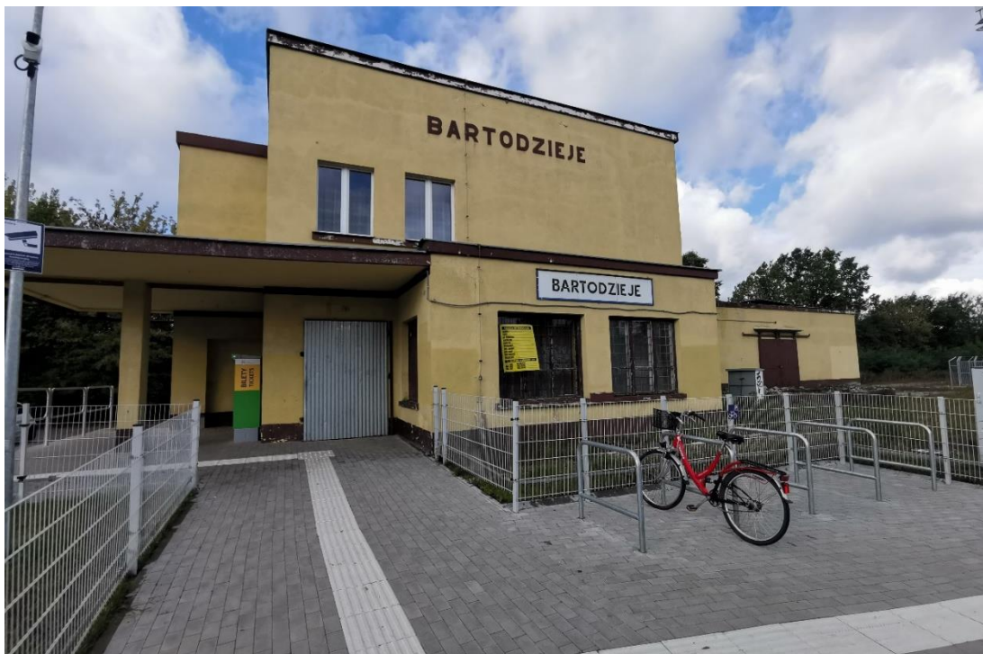
Fot. 7.1 Nowe stojaki rowerowe przy stacji kolejowej Bartodzieje.
