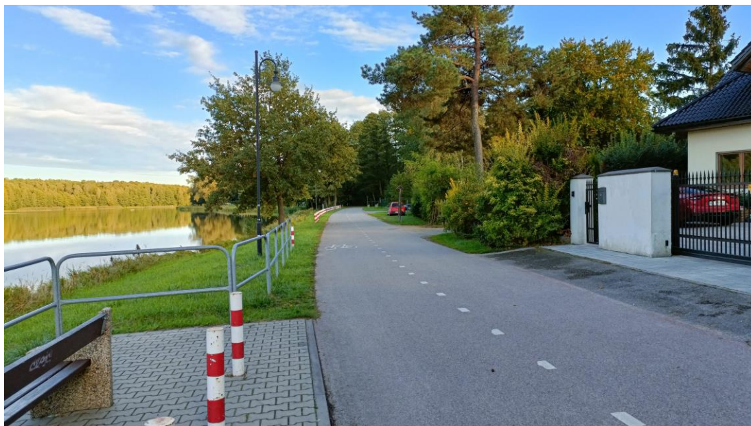
Fot. 7.5 Droga dla rowerów w Jedlni-Letnisko
