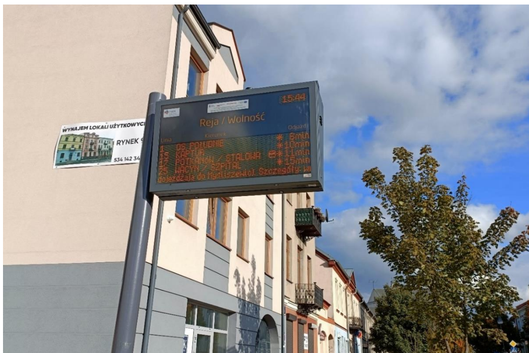
Fot. 7.3 System Dynamicznej Informacji Pasażerskiej w Radomiu.
