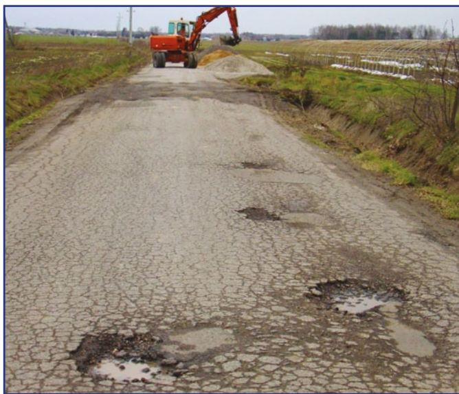
Prace remontowe na drodze Dęba-Glinice
